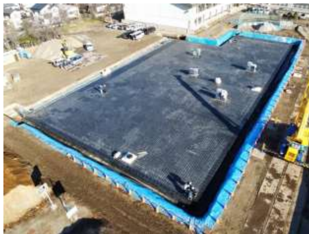
雨水貯留施設整備の様子
