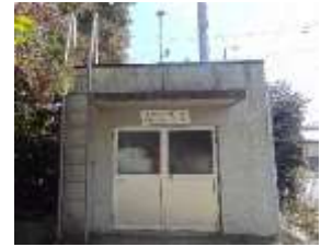
市役所敷地内の大気測定局
