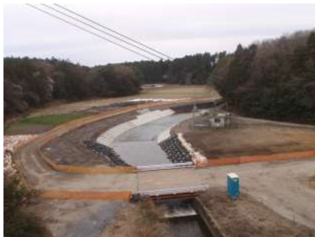
大川における河川整備の様子
