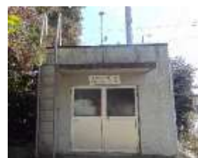
市役所敷地内の大気測定局
