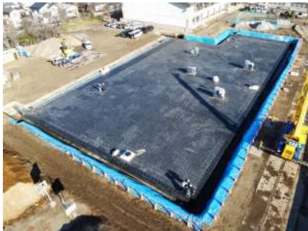
雨水貯留施設整備の様子
