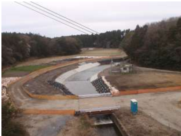
大川における河川整備の様子
