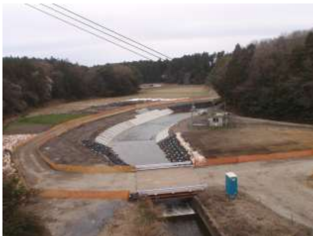
大川における河川整備の様子
