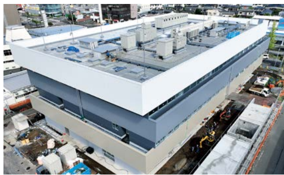
建設中の消防本部・笹野消防署庁舎
