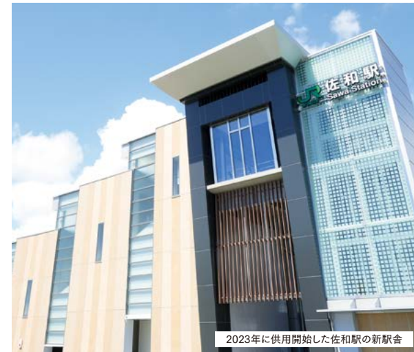
2023年に供用開始した佐和駅の新駅舎
