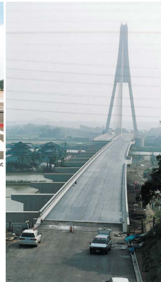
新那珂川大橋
