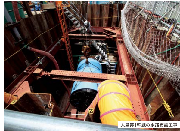
大島第1幹線の水路布設工事
