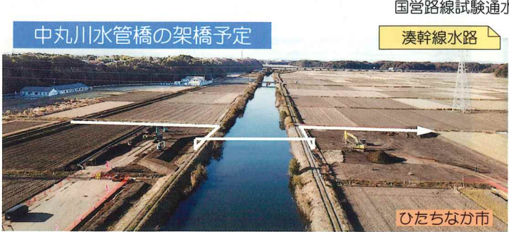
国営湊幹線水路 水管橋の架橋工事（引堤盛土造成工事）
