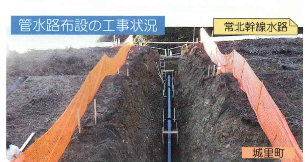
国営常北幹線水路工事（斜面管路埋設工事）
