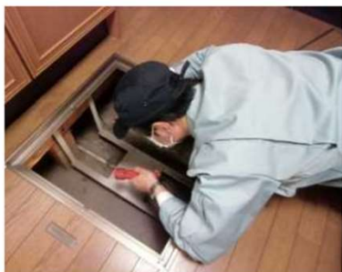
「土台・床組、基礎」調査の様子
