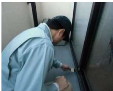
「外部（バルコニー）」調査の様子
