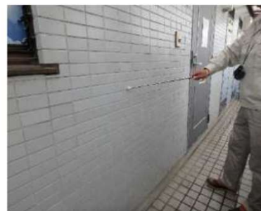
「外部（外壁）」調査の様子
