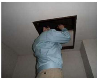
「小屋組・梁」調査の様子
