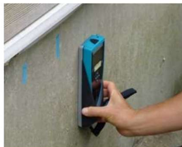
「基礎配筋」の調査機器
