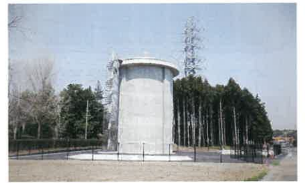
⑤水那幹線（新設）（戸崎調圧水槽）
