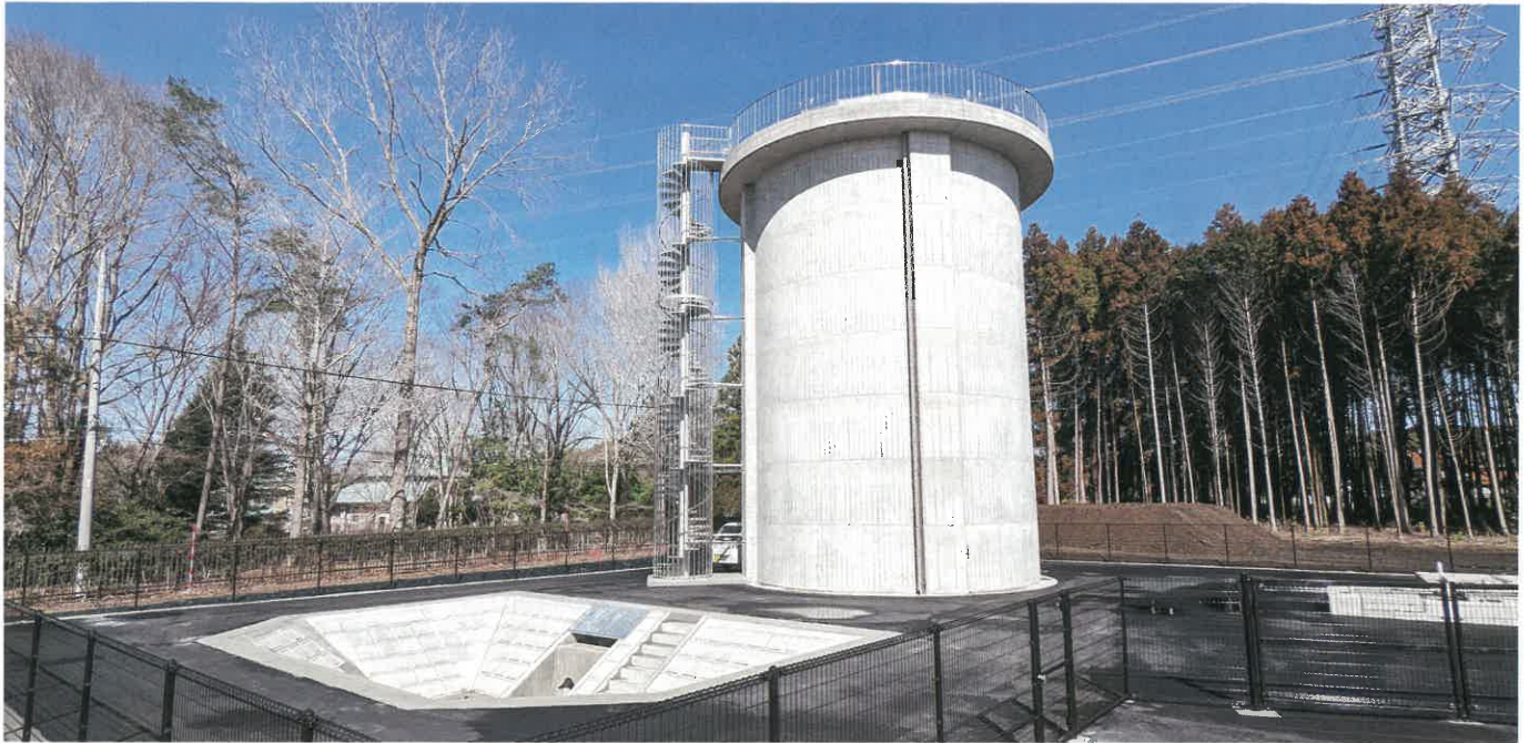
那珂市戸崎：東海村、ひたちなか市方面の受益地に安定送水するための水圧調整施設「戸崎調圧水槽」（令和3年度完成）
