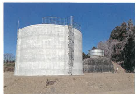
渡里吐水槽（改修）
