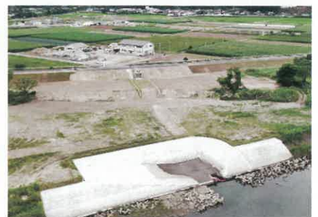
那珂川揚水機場（新設）
