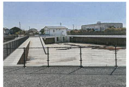
柳沢機場（新設）
