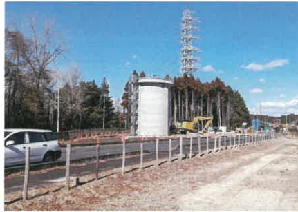
水那幹線（新設）（戸崎調圧水槽）
