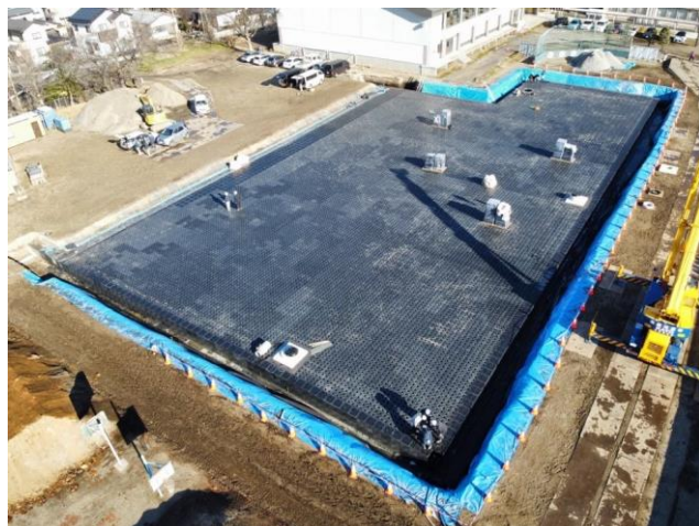
雨水貯留施設整備の様子
