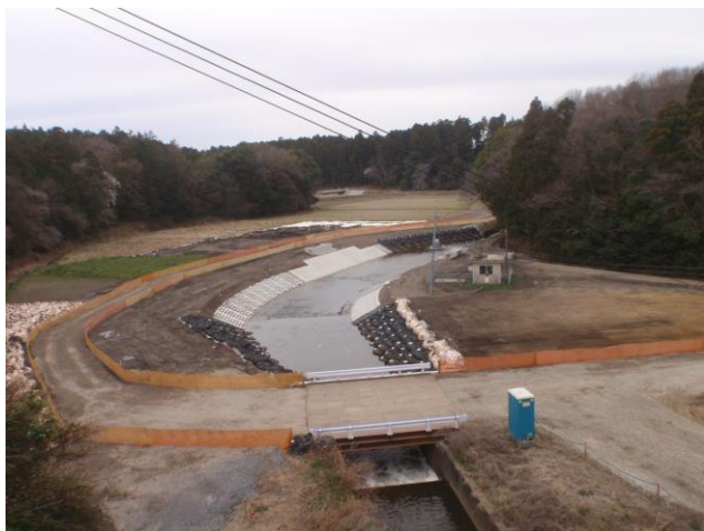
大川における河川整備の様子
