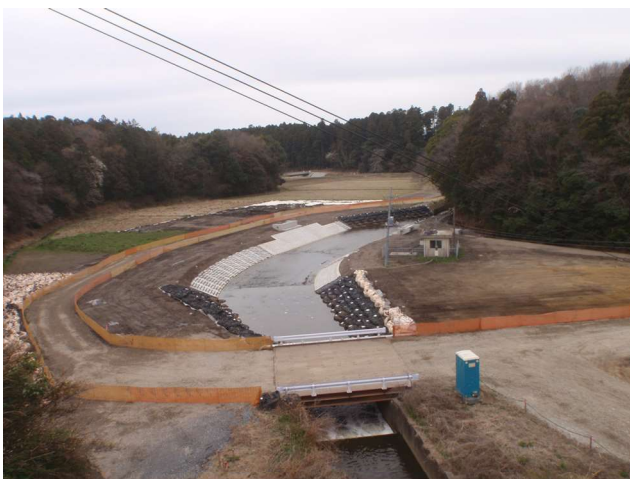
大川における河川整備の様子
