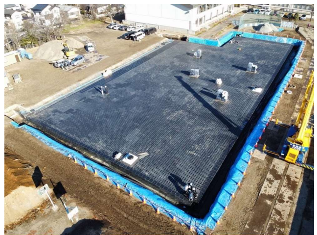
雨水貯留施設整備の様子
