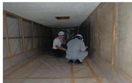
石綿(アスベスト)対策立入調査の様子
