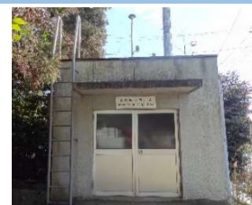
市役所敷地内の大気測定局
