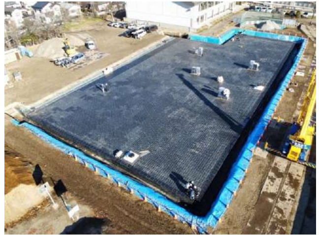
雨水貯留施設整備の様子
