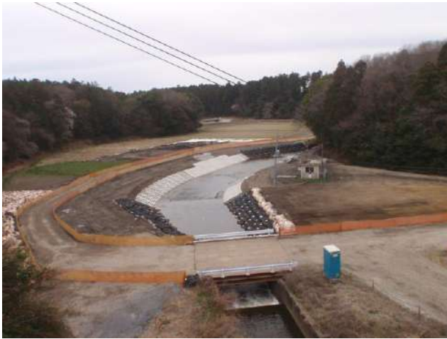
大川における河川整備の様子
