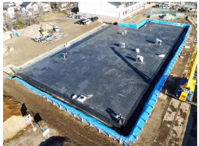
雨水貯留施設整備の様子
