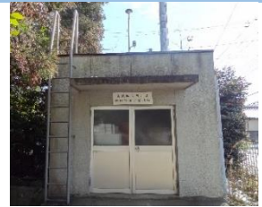
市役所敷地内の大気測定局
