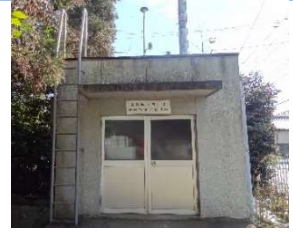
市役所敷地内の大気測定局
