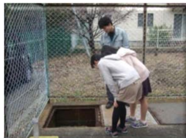
浄化槽を見学している様子
