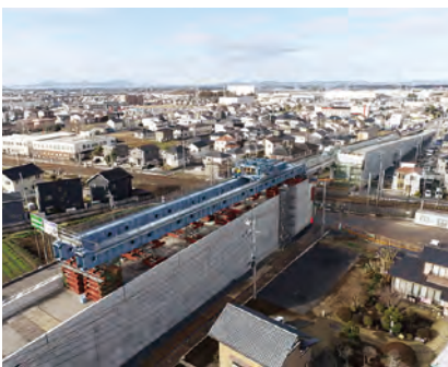
高場陸橋工事の様子（令和4年12月末）
