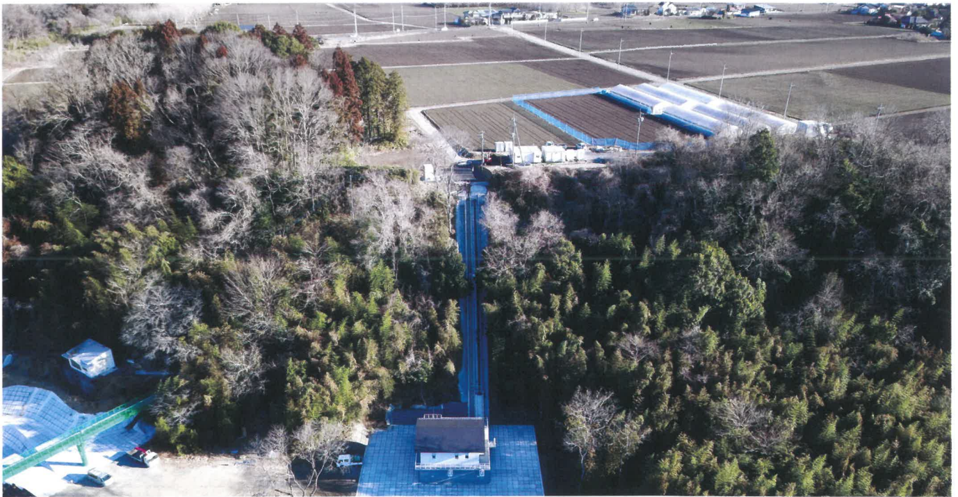
常陸大宮市三美：完成した三美機場と送水路及び台地に広がる畑総三美地区（令和3年度より稼働開始（試験通水）予定）
