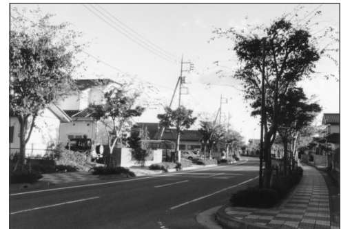
土地区画整理事業が完了した神敷台地区
