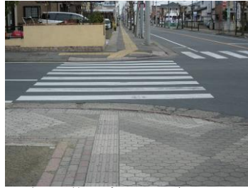
手前の誘導用ブロックは色が悪く目立たない
