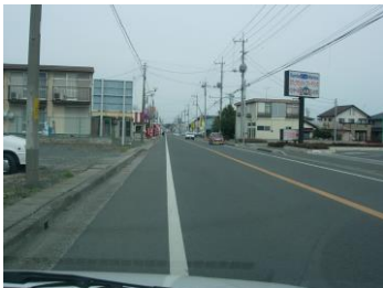
蓋がけした側溝と車道に段差があり、歩行することは危険
