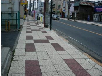
誘導ブロックがない。透水性が悪く雨天時お滑りやすい
