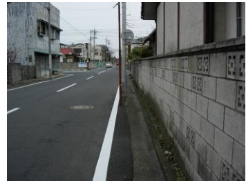
歩道は無く路肩には電柱が立っており、安全な歩行は困難
