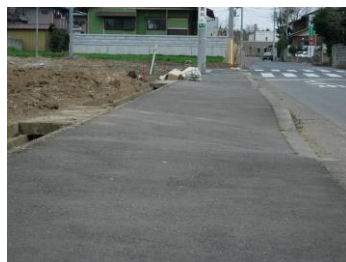
側溝に蓋が無く、横断勾配も2%以上ある
