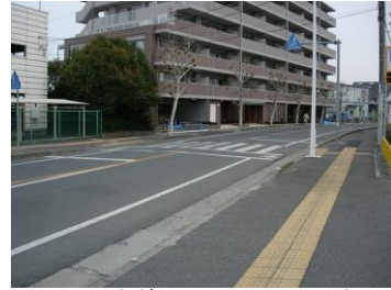
ここから歩道がマウントアップ※からフラットに切り変わる
