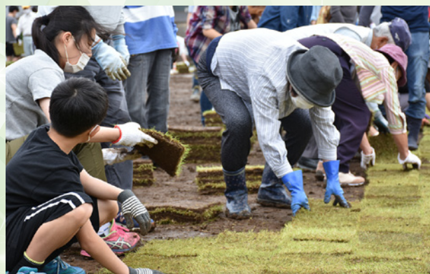
公園の芝張りを行う様子
