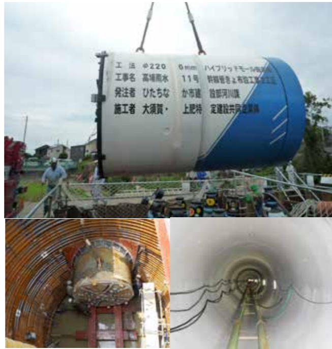
▲雨水の通り道となる雨水幹線整備
