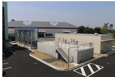
図 22 上ヶ砂配水場 (H26 完成)
