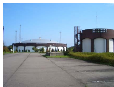
図 24 給水拠点（馬渡配水場）
