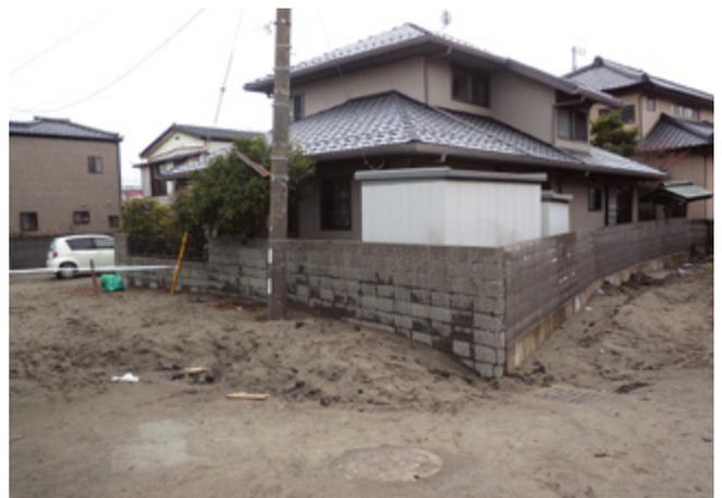
液状化による地面の隆起・沈下（海門町地内）
