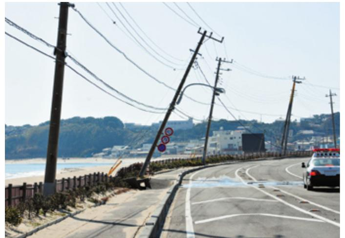
電柱の傾倒（阿字ヶ浦海岸）
