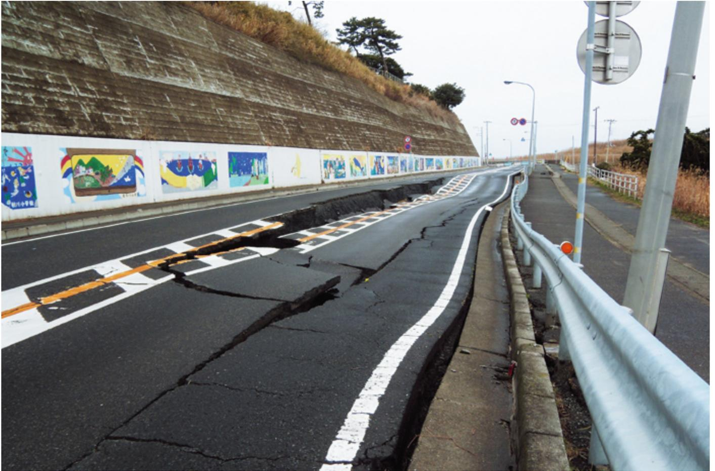
道路の亀裂や陥没（市道湊1-1号線）
