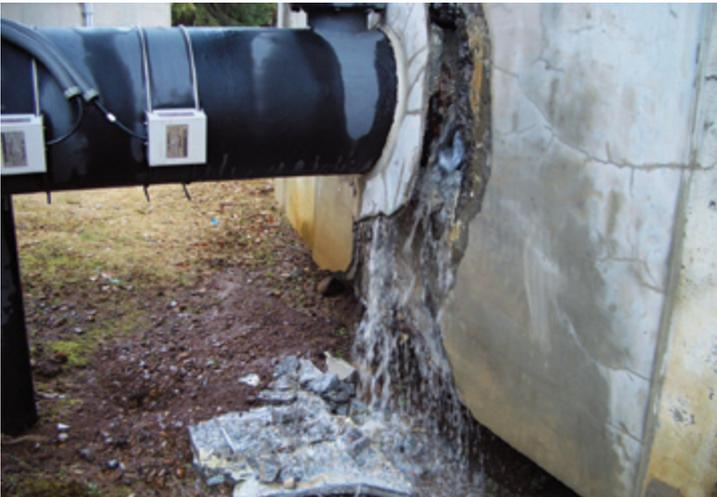
浄水施設の接合部破損（上坪浄水場）
