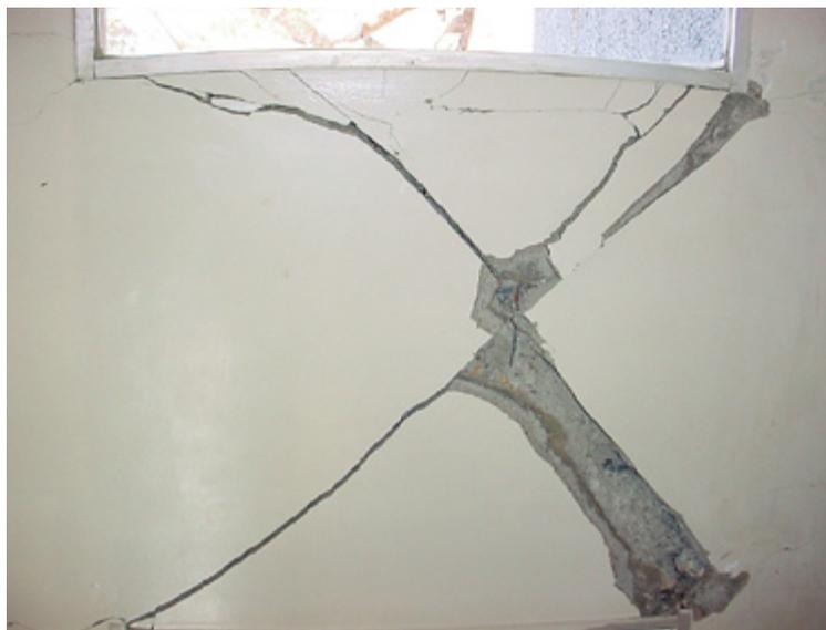
磯崎小学校校舎内の壁面の亀裂
