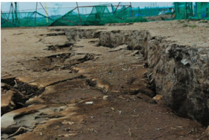
地盤沈下、亀裂が生じた那珂川グラウンド（勝倉地内）
