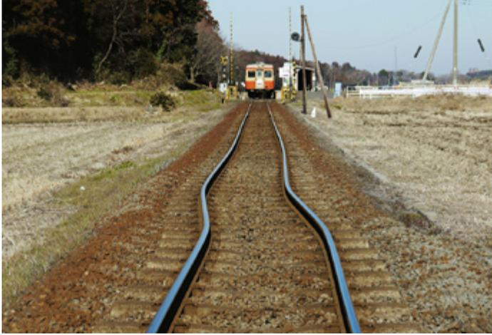
レールが湾曲し緊急停車したひたちなか海浜鉄道湊線（中根地内）
