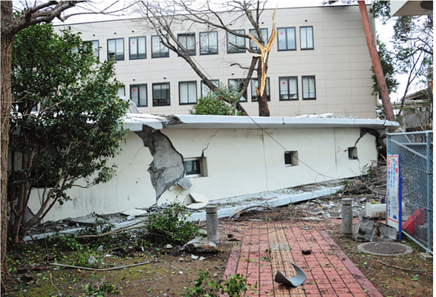
倒壊した市役所の高さ38mの煙突
