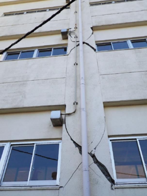
平磯小学校校舎の柱の亀裂
