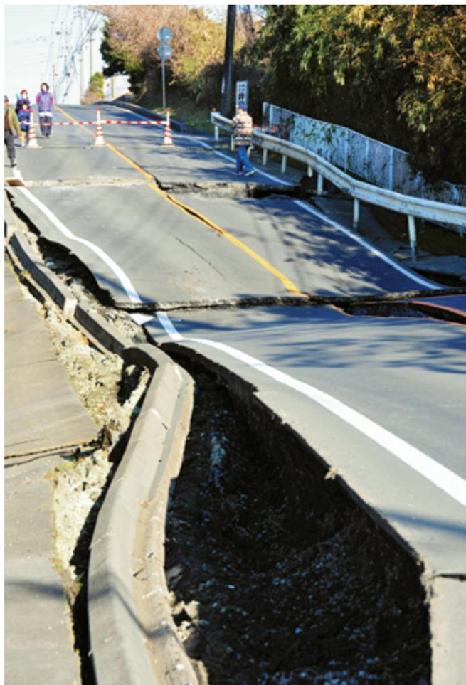
道路の断裂・沈下 (中根地内)
