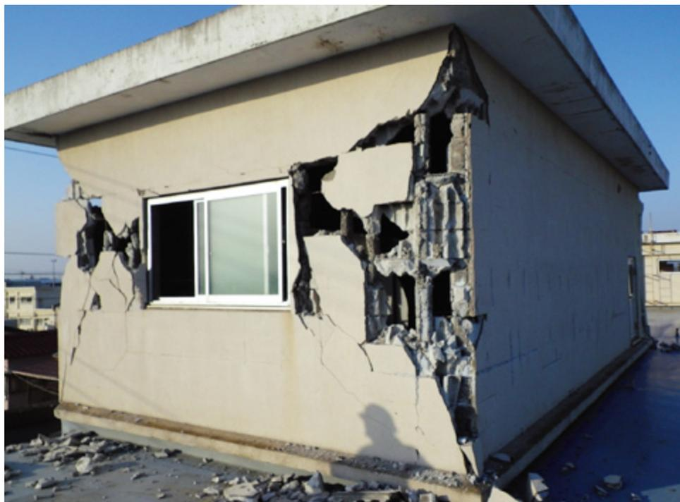
平磯小学校校舎屋上の機械室外壁の崩落
