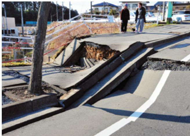
道路の断裂・沈下 (中根地内)
