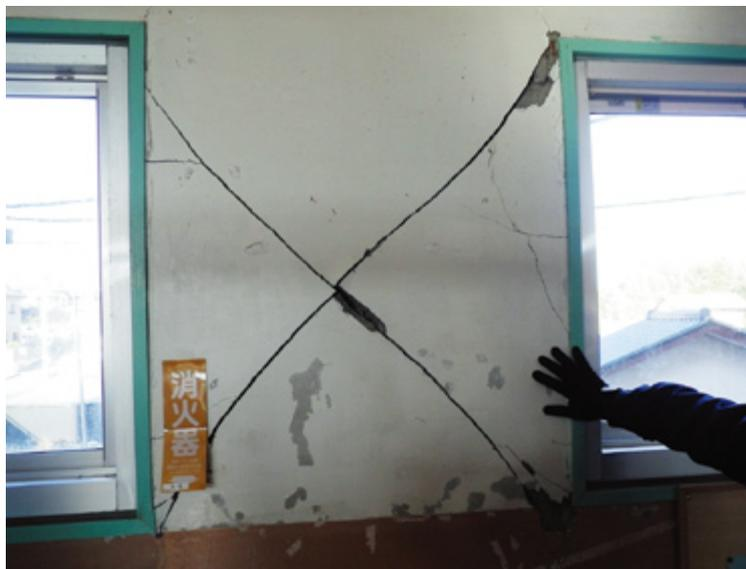
平磯小学校校舎の柱の亀裂
