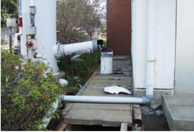
勝田清掃センターの煙突接続部の破損
