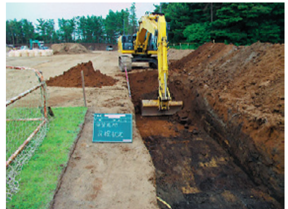
校庭の除染作業（平磯中）
