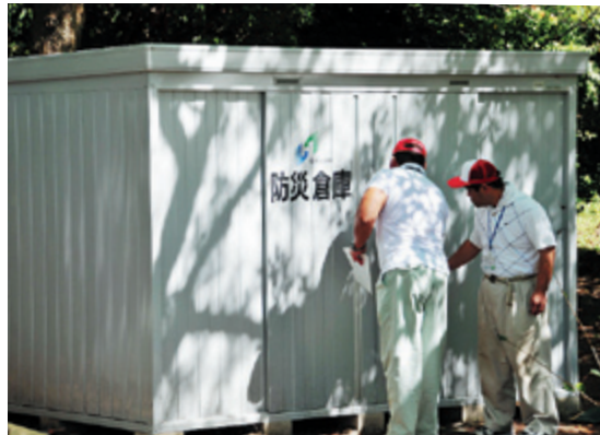
指定避難所に設置した防災倉庫
