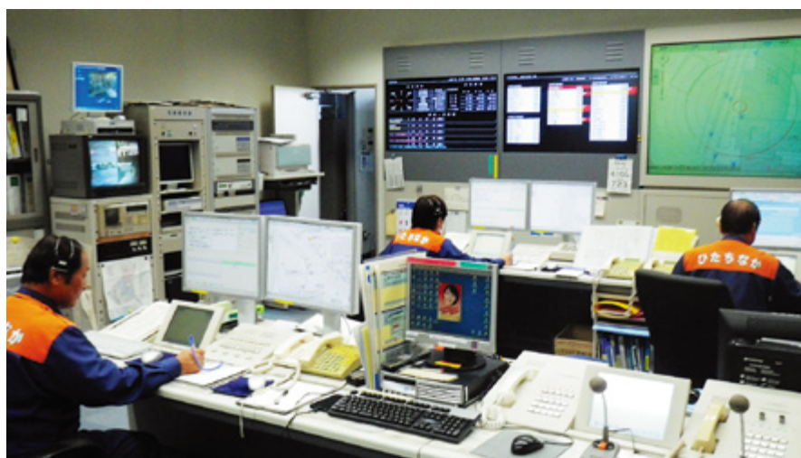
消防本部通信指令室
