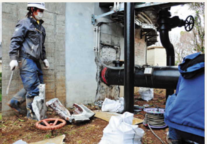
水道施設の復旧作業（上坪浄水場）
