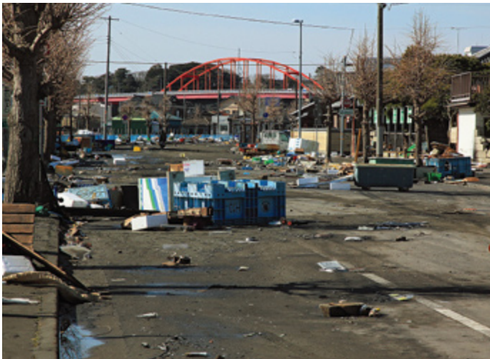
津波漂流ごみの散乱（湊本町地内）
