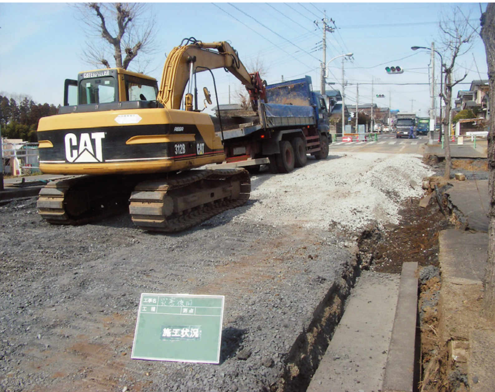
東中根向野線の復旧工事（中根地内）
