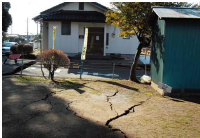
宅地内の亀裂
