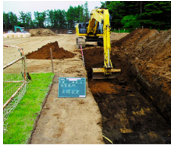
校庭の除染作業（平磯中）
