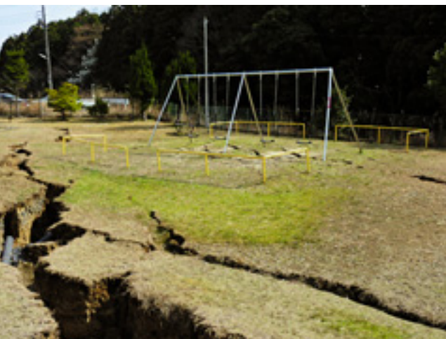
東中根第1公園の地割れ
