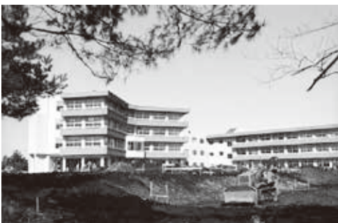
建設中の津田小学校(昭和51年4月)
