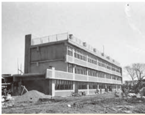
開校に向け建設が進む堀口小学校
