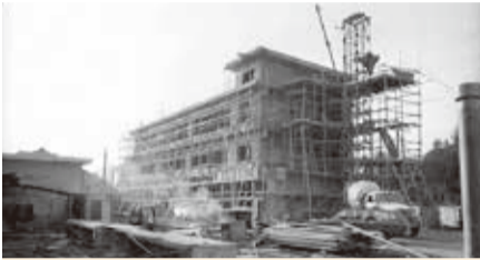
工事が進む(昭和45年2月)
