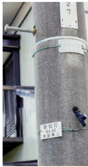
修理したプレート
