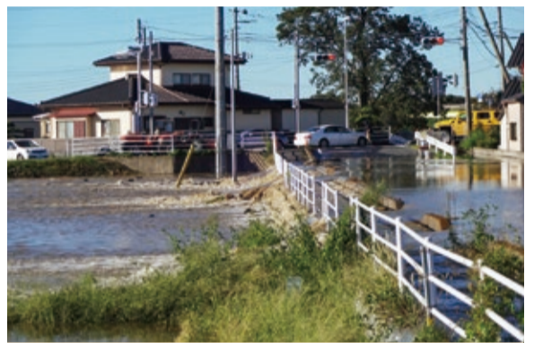
支流・早戸川より越水状況
