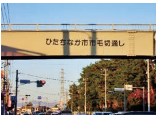
谷中前の国道の両側「切通し」
