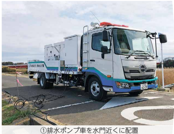
①排水ポンプ車を水門近くに配置
