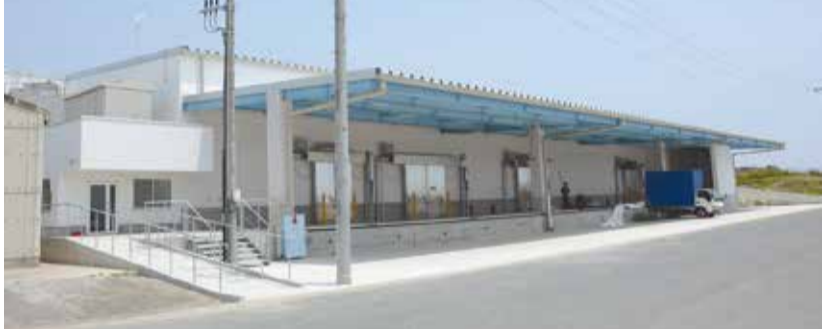
▲完成した新冷凍冷蔵庫
