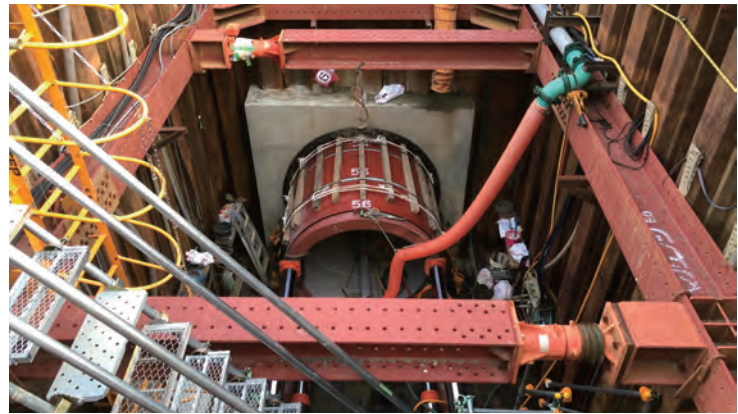
直径2mの雨水管
