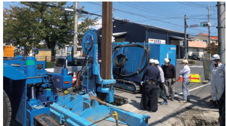
杭を押込む様子（圧入工法）
