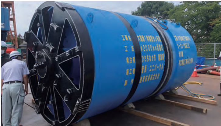
地中を掘り進める掘削機
