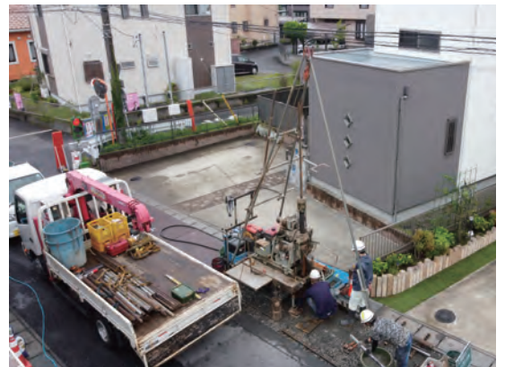
土質調査状況（ボーリング）
