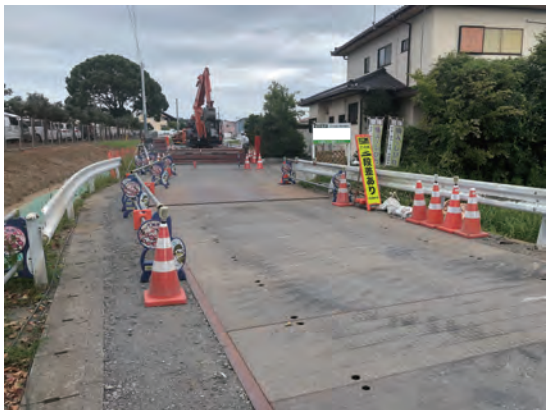
覆工板の設置状況
