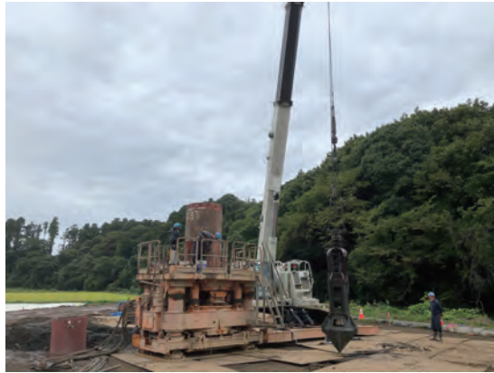
ケーシング工法による掘削
