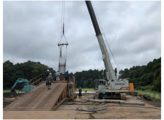
コンクリート打設前の鉄筋投入
