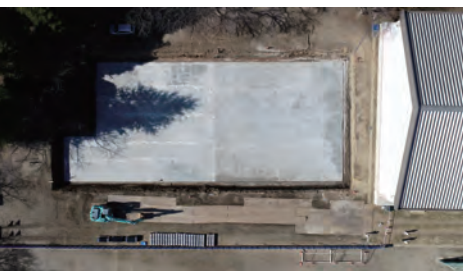
グラウンドの掘削と基礎の施工
