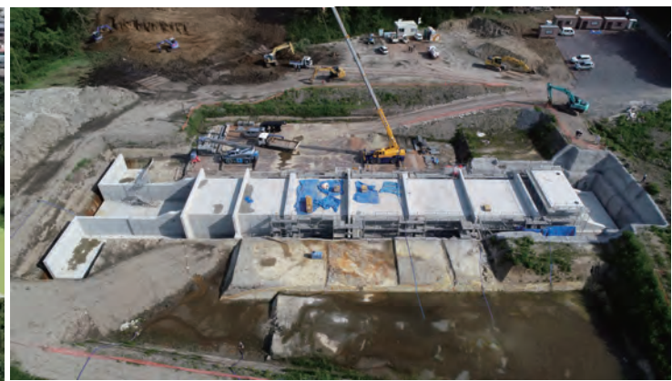
令和3年5月末日の施工状況
