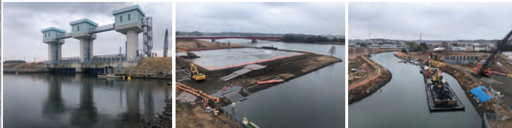
←左側の写真、中丸川水門の上流側の土砂撤去の作業状況。右側の写真、掘削した土砂の天日乾燥を行う作業状況。【2月16日現在】
