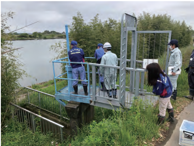
施設本体の状況確認
