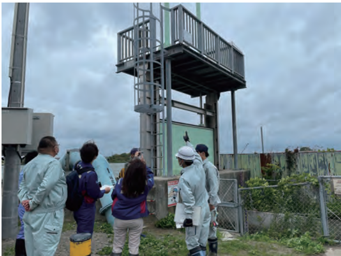
施設本体の状況確認
