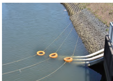
排水ポンプ設置状況
