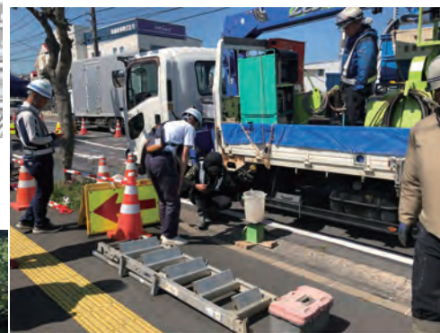
▲上段写真は、シールド工法による管きよを布設するライン上のボーリング調査、順に、地盤改良工の材料検査、下段は、地盤改良工実施の動作確認の様子。
