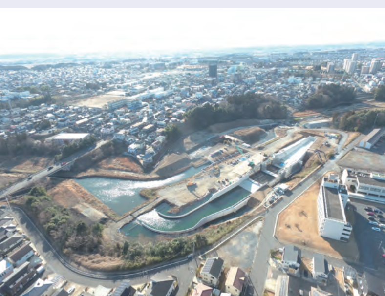
↑中丸川調節池を下流から撮影
