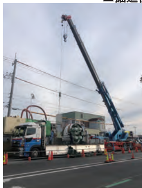
▲掘進機の1回目搬入
