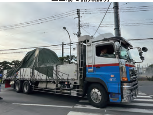
▲大型トラック搬入
