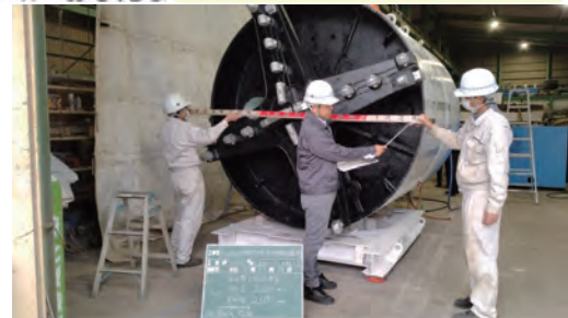
▲掘進機の寸法検査
