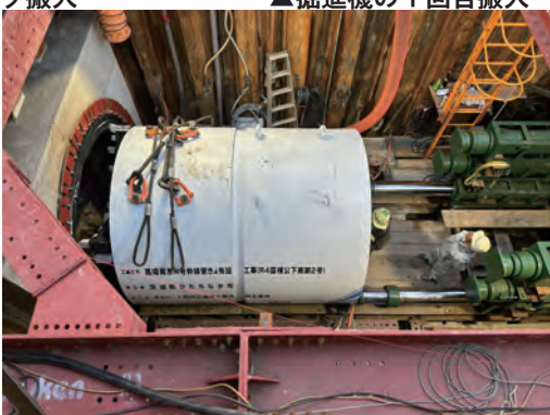
▲発進立坑に積卸
