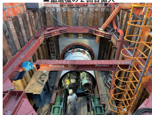
▲発進立坑で組立状況
