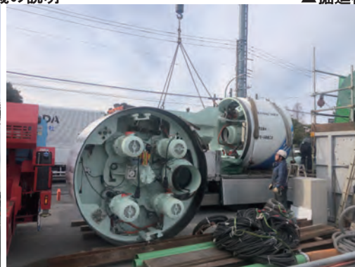
▲掘進機の2回目搬入
