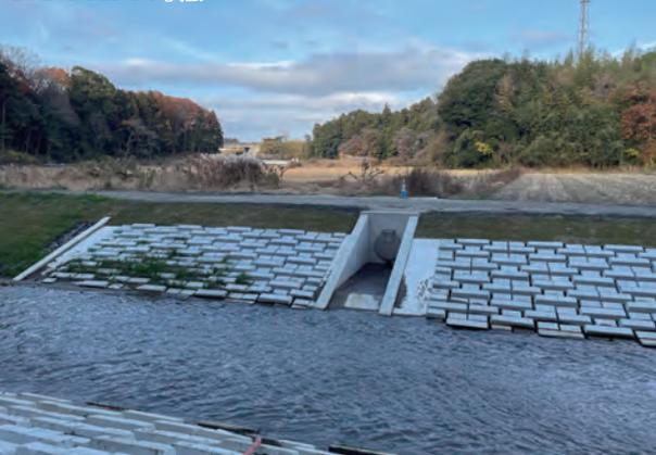
▲大川へ排水する排水管の吐出口です。▶大川の施工状況です。大型連結ブロックを設置しています。
