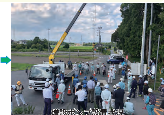
増設ポンプ設置状況
