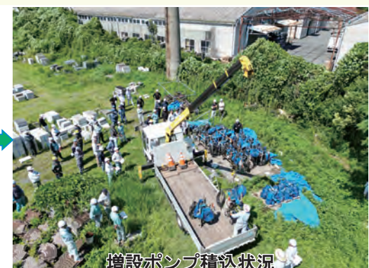
増設ポンプ積込状況
