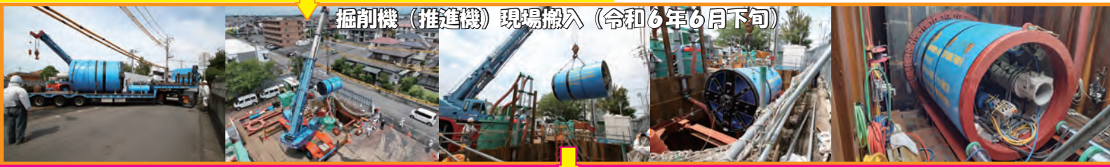
◀左の写真は、工場検査状況：上段の左から、掘削機諸元説明→掘削機①：側面→掘削機②：全体→掘削機③：全面→掘削機④：裏面→掘削機⑤：確認 ▼下の写真は、掘削機現場搬入状況：左から、搬入→吊上げ①→吊上げ②→吊上げ③→吊上げ④→立坑内に設置
