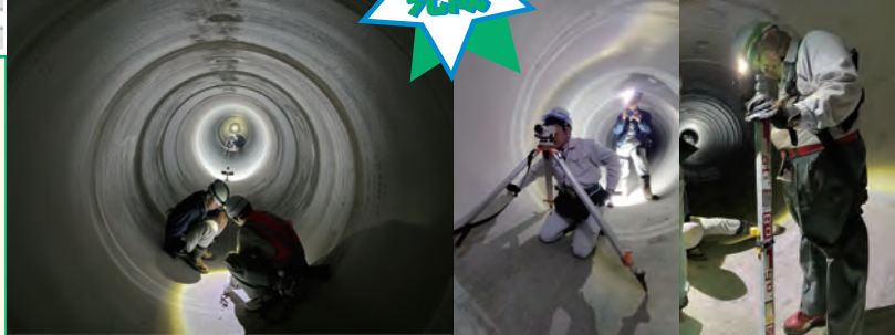
▲上段左から、課内検査の説明→管きょ出来形・出来映え確認 下段左から、管延長測定→管きょ高測定→管きょ高測定（スタッフ：目録）
