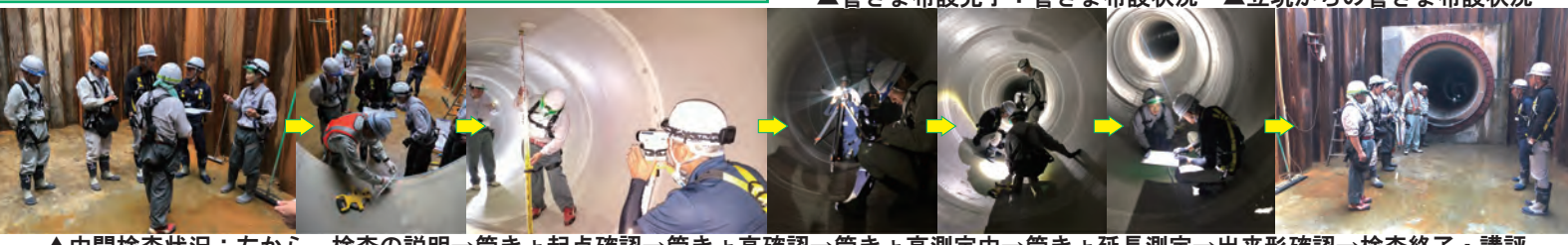
▲中間検査状況：左から、検査の説明→管きょ起点確認→管きょ高確認→管きょ高測定中→管きょ延長測定→出来形確認→検査終了・講評
