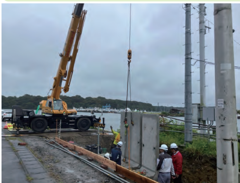
←堤防計画高に合わせて設置されるL型擁壁
