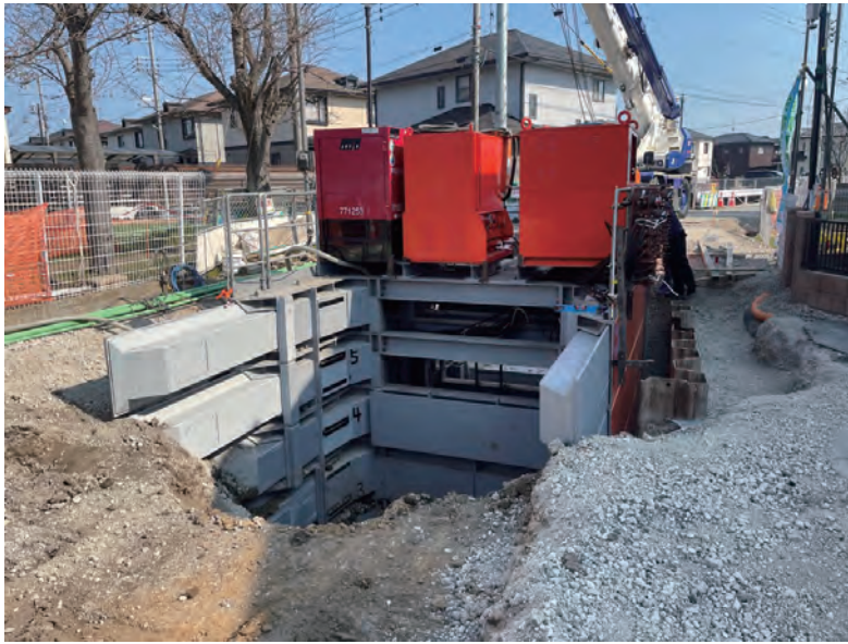
作業箇所が上から見えるため「オープン」シールドと呼ばれます。
