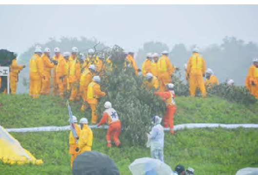
水防工法・木流し工
