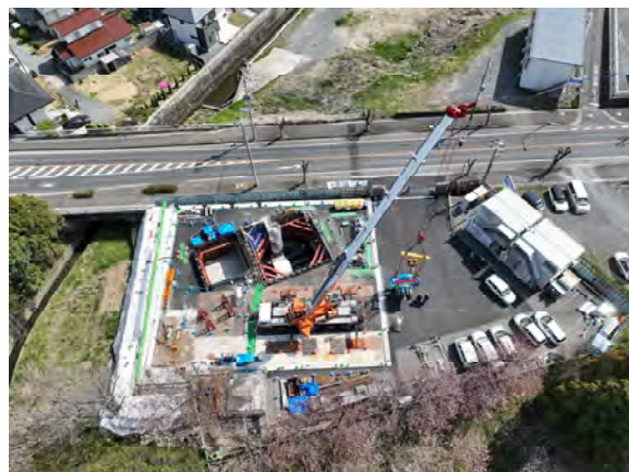
▲上空からの工事現場
