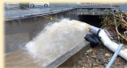
排水ポンプ車活動の様子
