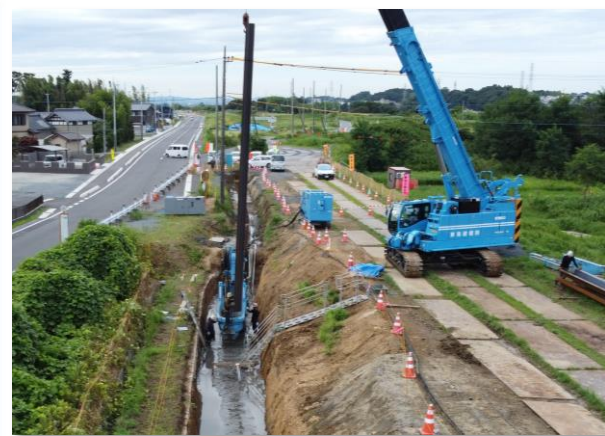
鋼矢板の設置
