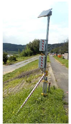
危機管理型水位計 那珂川左岸40.25k
